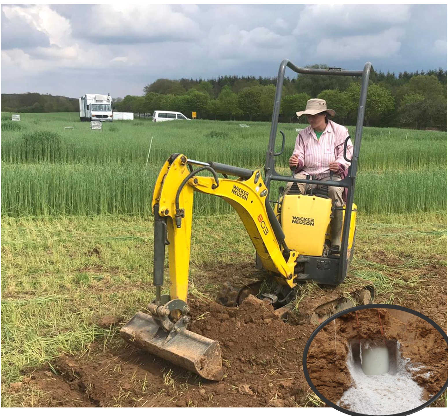
Installation von dauerhaften Nitratmessgeräten (SIA) im Boden
